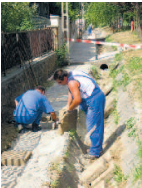
Járdafelújítás és új járda építése a Honvéd utcában
