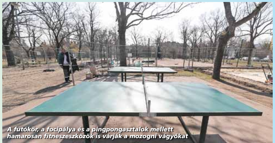
A hideg, téli időszak elmúltával ismét a szakemberek vették birtokukba a Vérhalom teret, hogy befejezzék a sportpálya felújítását. Nemcsak öntöttgumi burkolatot kap a focipálya, hanem olyan kerítés épül köré, amely csillapítja a zajt, ha rápattan a labda
