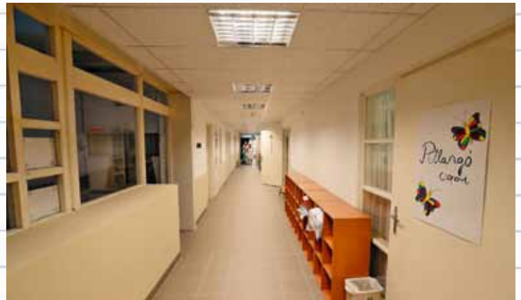
A Törökvész Úti Kézműves Óvodában átépítették a kazettás álmennyezetet és a világítást, valamint átépítették a beltéri folyosó falburkolatát, amit le is festettek
